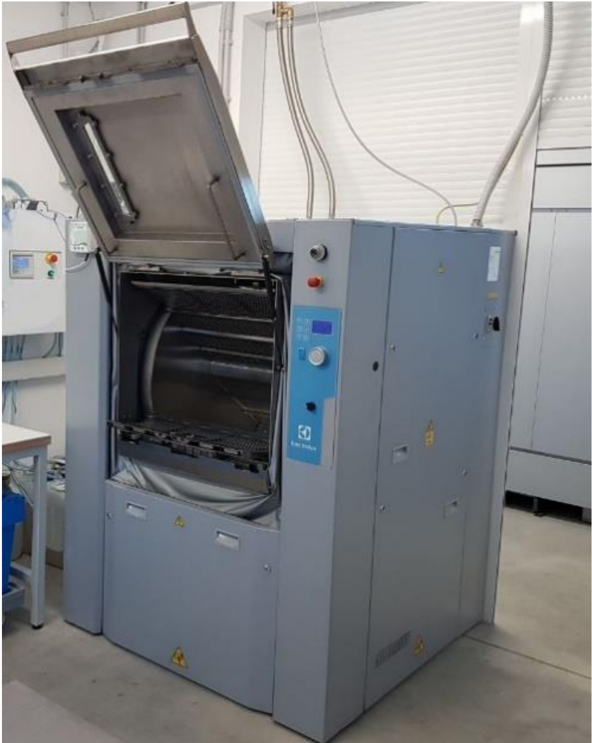
Bild 2. Barriärvättmaskin på brandstationer som möjliggör uppdelning i en kontaminerad zon och en ren zon av lokaler för hantering av t.ex. larmställ och andningsmasker.
